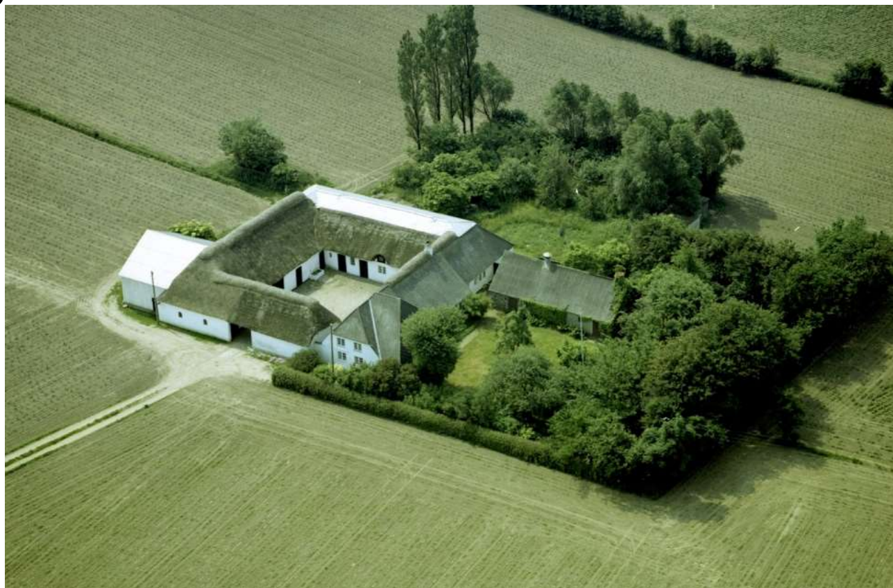
Gård ved Strandby, Fyn 1978-1980
